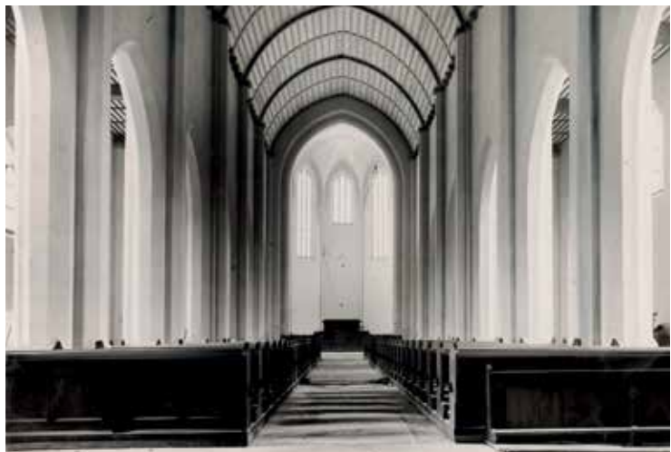
Innenraum der Andräkirche während des Wiederaufbaus.
